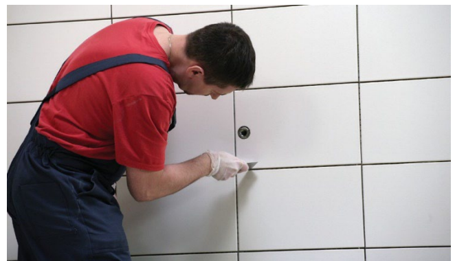
Čišćenje fuga pločica prije fugiranja
