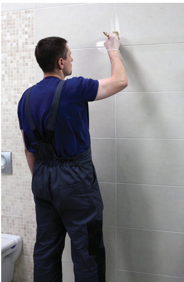
Spoj se može dodatno zaštititi silikonskom impregnacijom Ceresit CT 10
